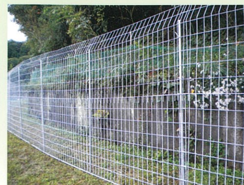
滋賀県大津市 忍び返し施工例
