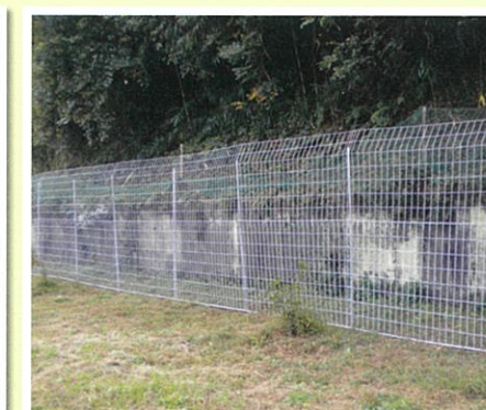
滋賀県 大津市 距離: 90000m / 施工時期: 平成22~23年
